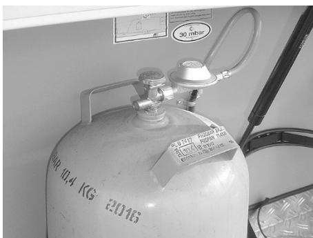
Afb. 107: Gasfles met drukvermindingsklep
