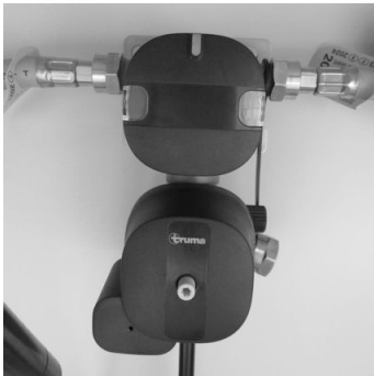
Afb. 83: Gasinstallatie (met Eis-Ex en display op afstand)
