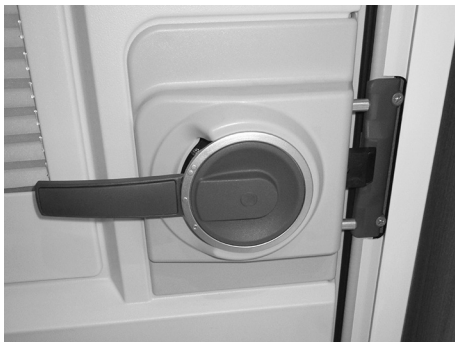
Fig. 15 : Serrure de porte fermée mais non sécurisée
