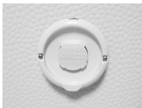
Fig. 89 : Conduit d'évacuation des gaz brûlés (sur la paroi)
