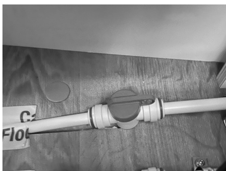
Fig. 93 : Vanne du chauffage au sol ALDE
